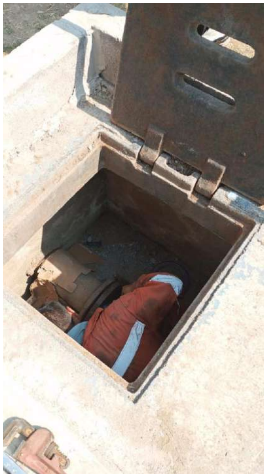
Ilustración 1 Instalación de válvula
