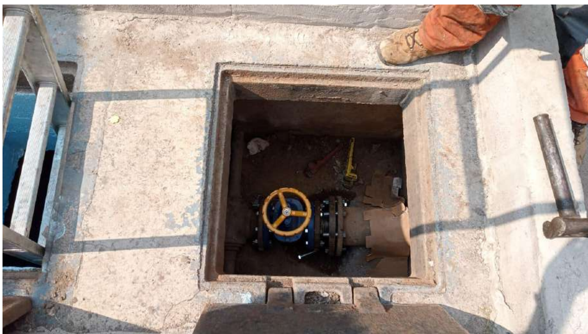
Ilustración 2 Válvula instalada
